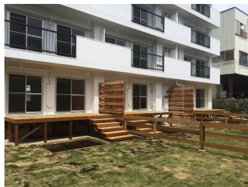
4号棟1階居室専用庭
