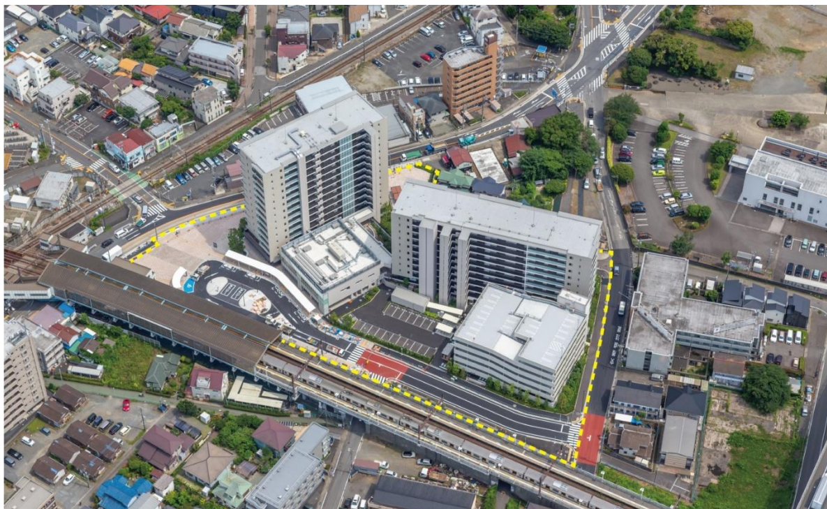
厚木駅南地区第一種市街地再開発区域全景 ※破線の枠内が施行区域
